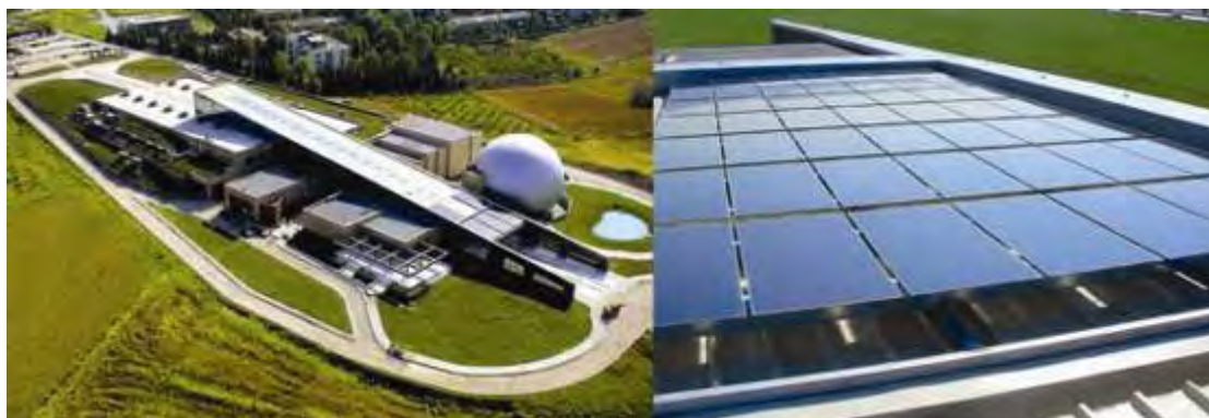
Ενσωμάτωση άμορφων φωτοβολταϊκών στο Τεχνολογικό Μουσείο Θεσσαλονίκης
