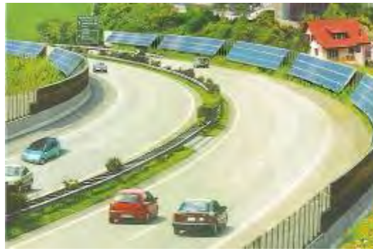
Εφαρμογή φωτοβολταϊκών σε ρόλο ηχοφράγματος σε αυτοκινητοδρόμους
