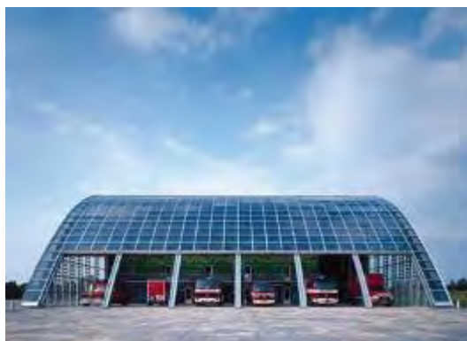
Ενσωμάτωση φωτοβολταϊκών σε πυροσβεστικό σταθμό
