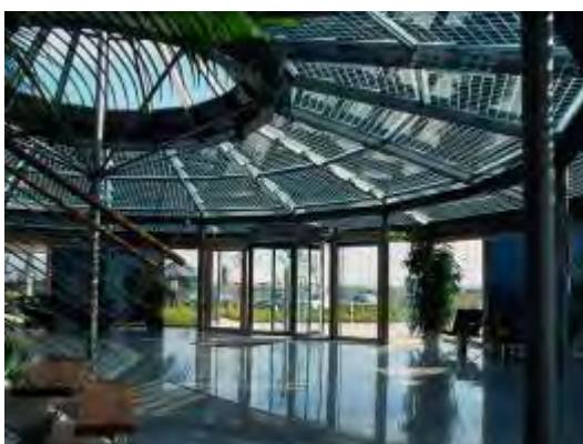
Εφαρμογή φωτοβολταϊκών που επιτρέπουν τη διέλευση φυσικού φωτός σε εμπορικό κτίριο
