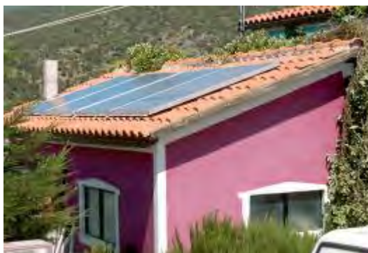
Εφαρμογή φωτοβολταϊκών σε κεραμοσκεπή εξοχικής κατοικίας
