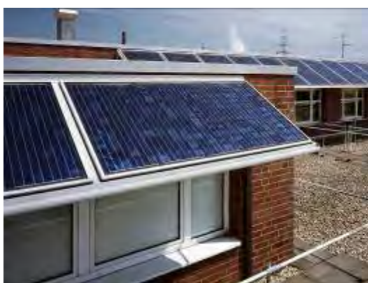
Φωτοβολταϊκά σε ρόλο σκιάστρων
